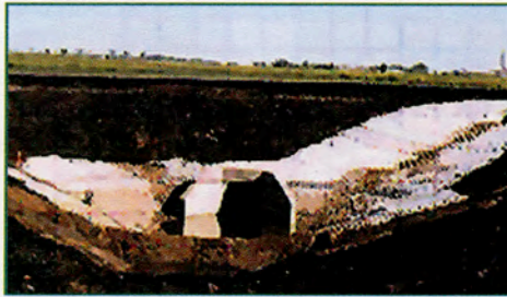
Εικόνα 5.18: Εφαρμογή γεωυφάσματος σε αποχετευτικό έργο
